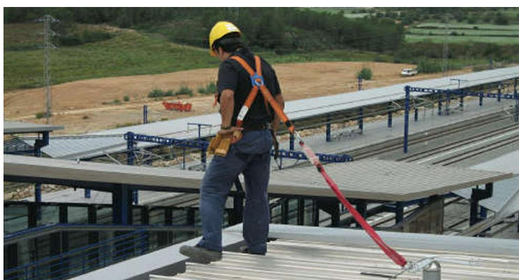
EJEMPLO DE USO DE LÍNEAS DE VIDA EN EL SECTOR DE LA CONSTRUCCIÓN
